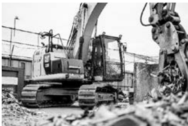
工場内作業①
